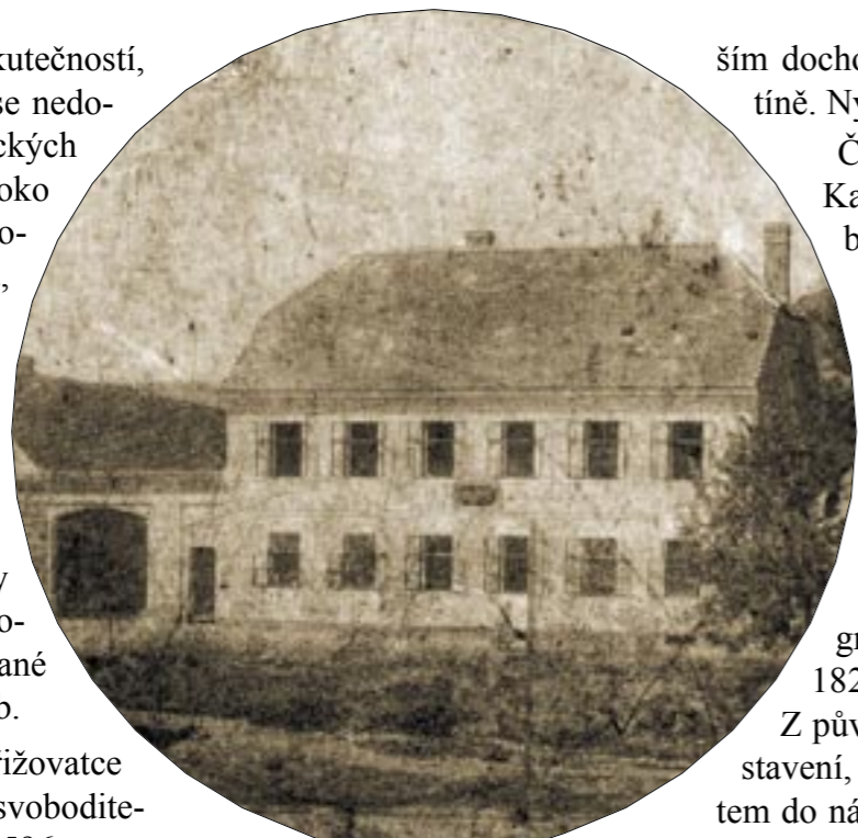
Dům čp. 6, grunt Havlovský
